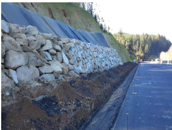
Ejecución de Cunetas de Hormigón, Dm. 46.000, Sector A
