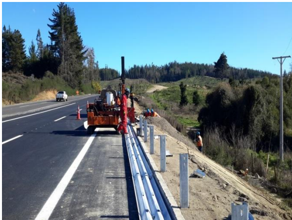
Instalación de Defensas Metálicas Triple Honda, Dm. 44.050, Sector A
