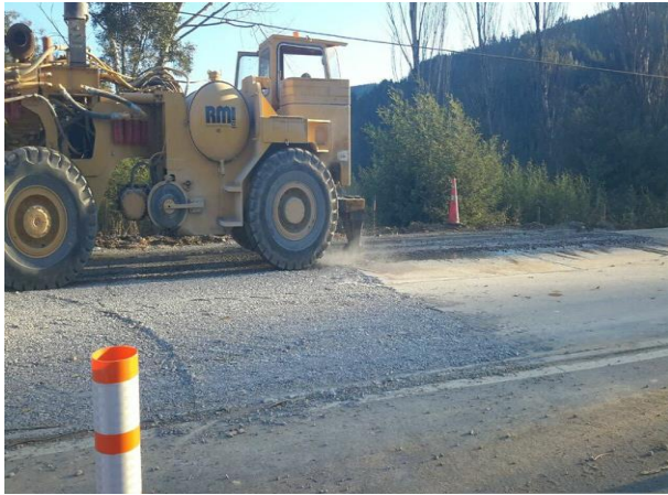
Pulverización Pavimento de Hormigón (Rubblizing) y Colocación Carpeta Asfáltica, Tramo Dm. 68.000 – Dm. 70.000, Sector A
